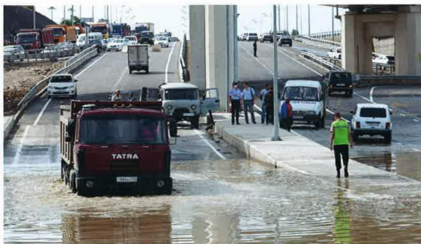
Фото 2. Подтопление участка федеральной трассы
