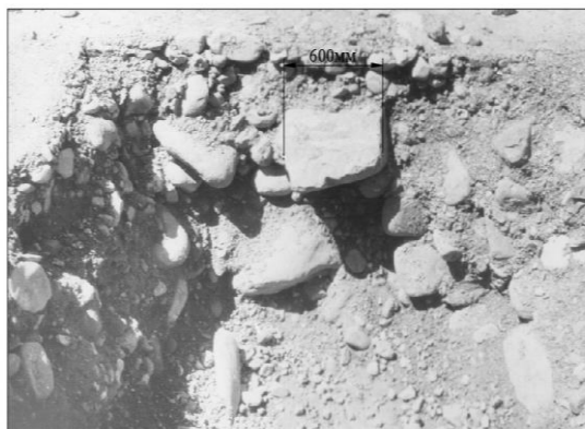
Рис.1. Опытная насыпь из гравийно-галечникового грунта в теле плотины Рогунской ГЭС:
